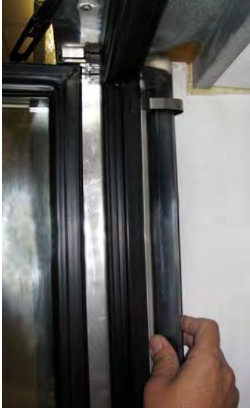
Step 1: Shut-off power; detach lens clips and remove ELS lens.
